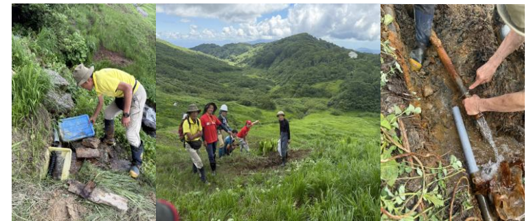
小屋引込み水源地修繕工事 2025(R7)/08/03
